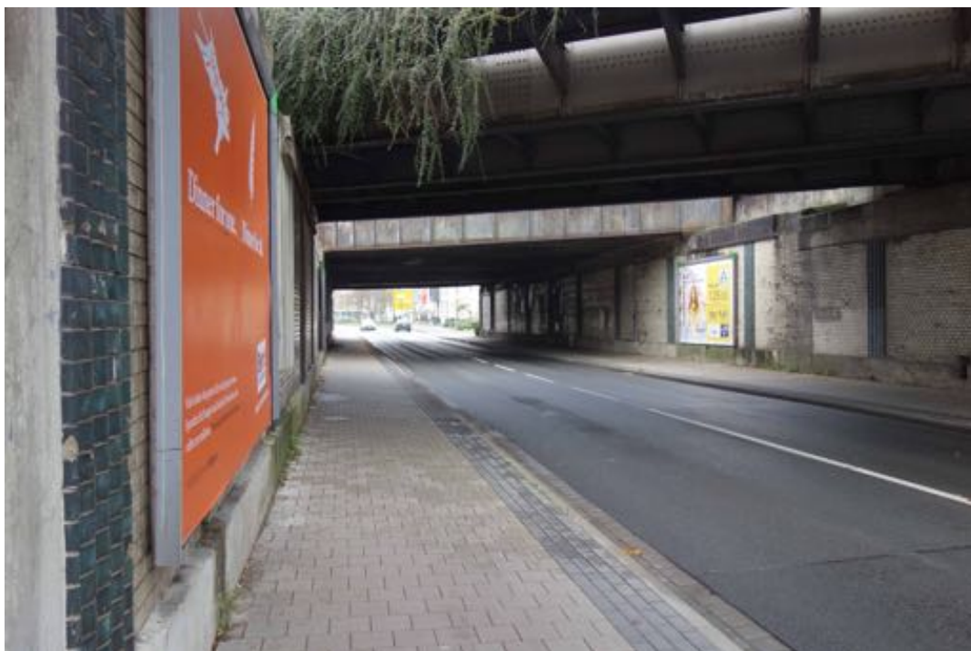
Abb.: Unterführung Herzebrocker Straße, WoltersPartner
